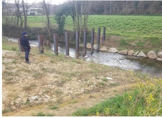
*Exemples de pièges à embâcles sur la Deûme à Annonay (07) et sur la Sévenne à Vienne (38)*
