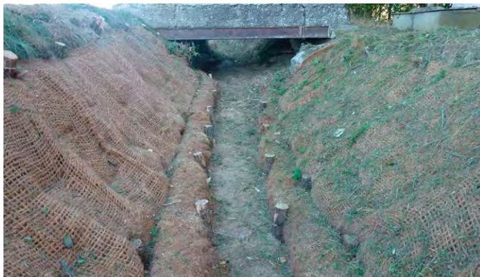
Fascine de « boudins coco » sur la Raie Brunet
