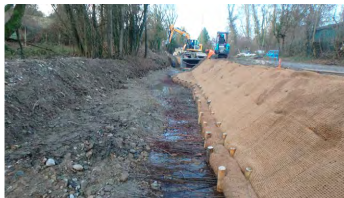
Stabilisation des berges et mise en place du pont en cadre préfabriqué
