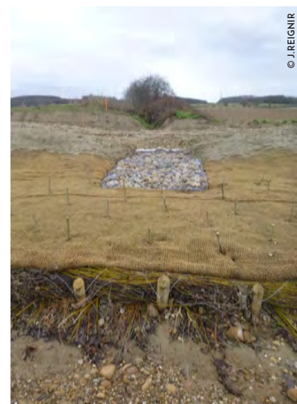
Matelas gabion à la confluence d'un affluent
