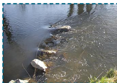
Amas de blocs en berge
