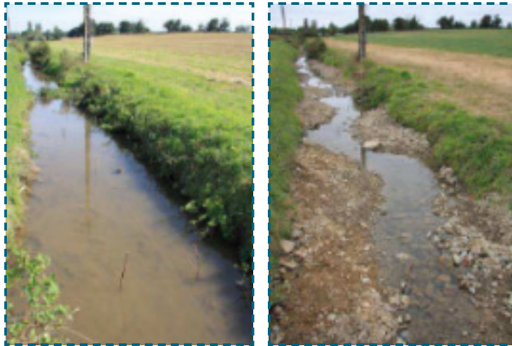
Exemple de travaux de recharge en granulats et reméandrage
