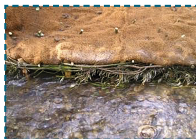
Sous-berges en génie végétal
