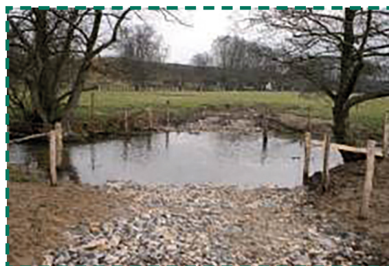
Passage à gué stabilisé (PNR du Morvan, 2001)
