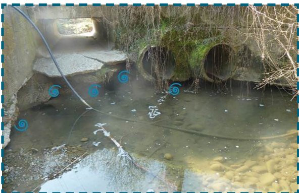
Reprise du radier de l'ouvrage et de la berge en rive droite sur 120 m sur le Charantonge
