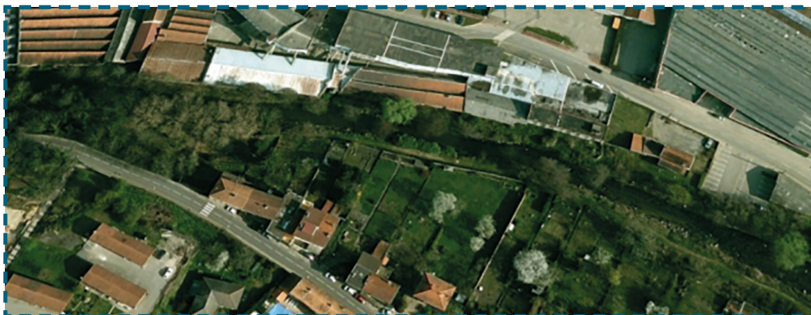
Linéaire de la Gère au droit de l'ancienne Usine de Bocoton
