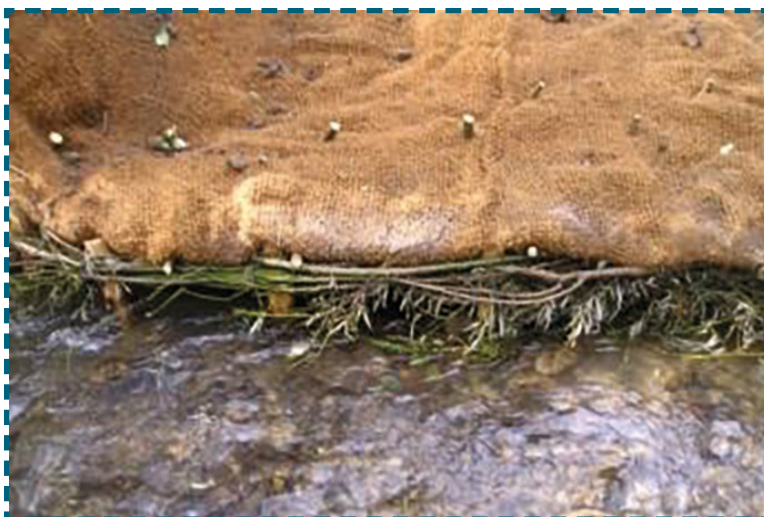
Sous-berges en génie végétal
