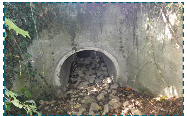
Projet de remplacement des buses par un portique sur la Suze amont (PT_SUZ_12)
