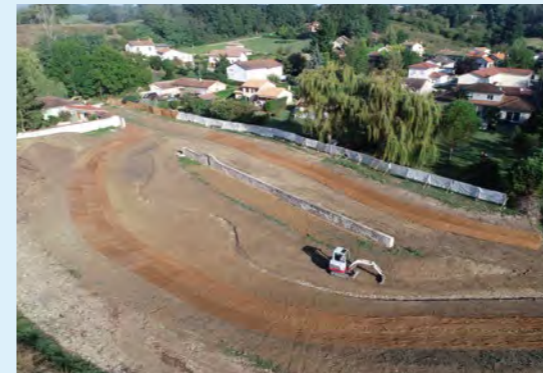
Vue de drone des travaux sur la Vesonne au centre village de Moidieu Détourbe © actua drone
