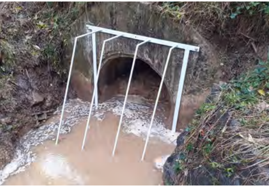
Grille de protection de la buse sur la Combe Bleue
