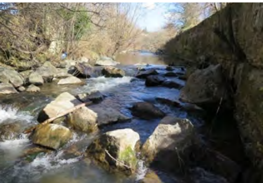
Berges en mauvais état écologique sur la Gère à Eyzin-Pinet
