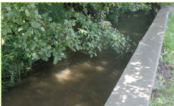
Canal de Montjoux à l'entrée de Saint-Jean (unité GDV.1)
