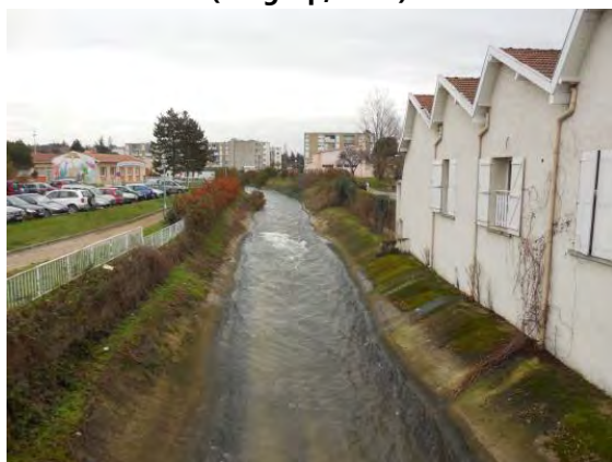
Figure 18 : Recalibrage et cuvelage béton des Collières à Saint-Rambert-d'Albon (Burgeap, 2016)
